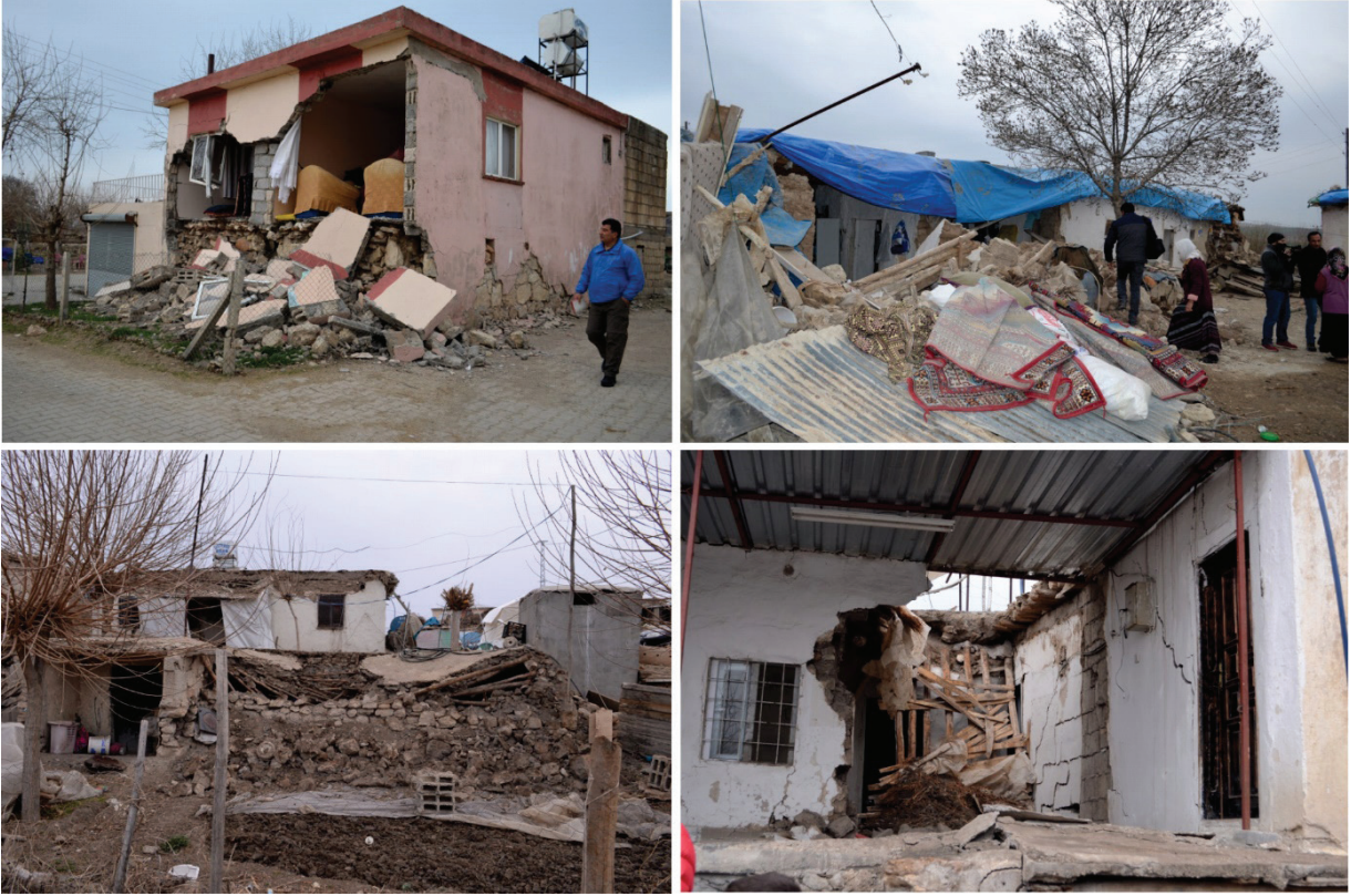
Şekil 4. 2 Mart 2017 depreminden sonra Samsat kuzeyinde Akdamar ve Taşkuyu köylerinde oluşan yapısal hasarlar. Figure 4. Structural damages in Akdamar and Taşkuyu villages located in north of Samsat after 2 March 2017 earthquake.
